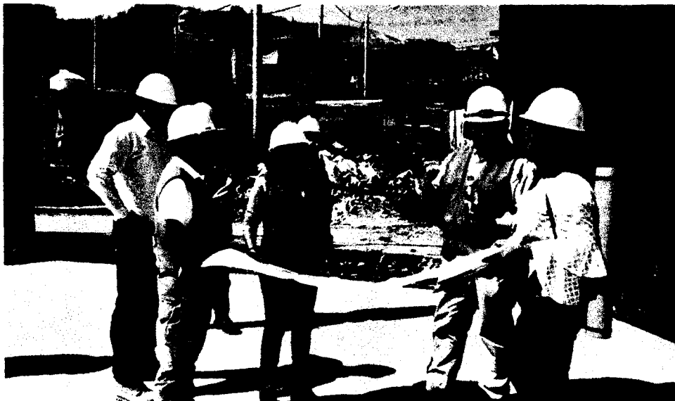
Foto 29: Representantes de FONDEPES recorren las instalaciones de la obra acompañados del Supervisor de obra y miembros del Consorcio
