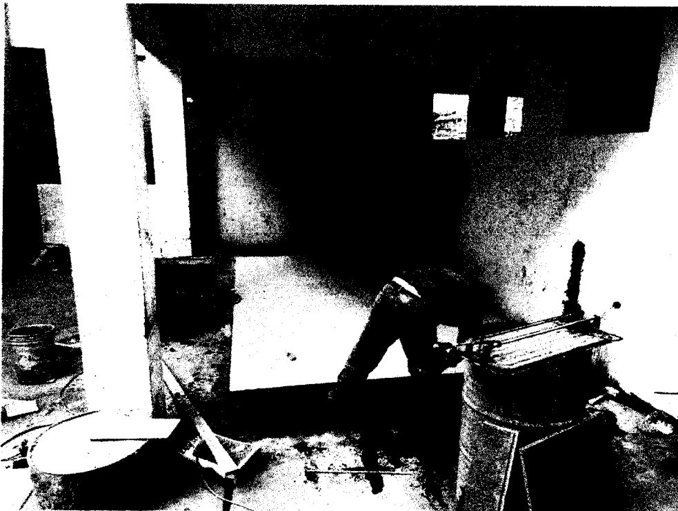
FOTO N° 06: Instalación de porcelanato en piso y contra zócalo de patio de redes, Edificio Servicios Complementarios.
